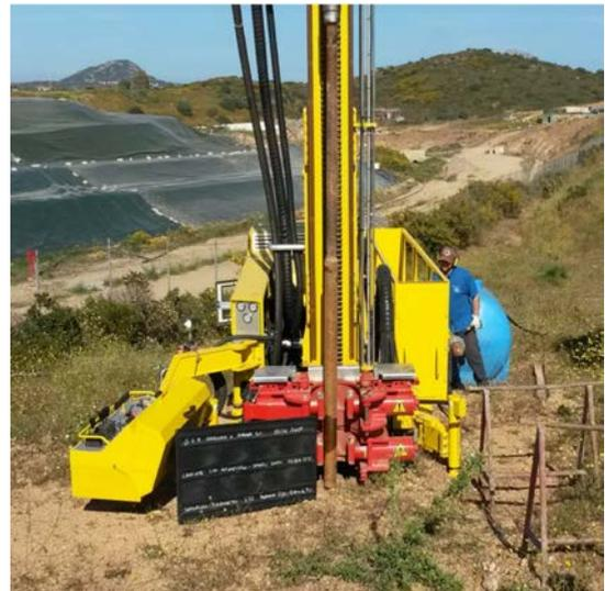
La perforazione (Ø101/127) è stata spinta sino ad una profondità di -10,00 m da p.c. per ciascun punto di campionamento.
